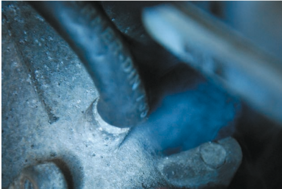
Leckage gefunden: Aus einem defekten Schlauch tritt der Rauch aus.
